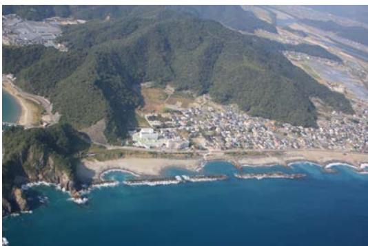
〔侵食対策事業の状況（新居海岸）〕
