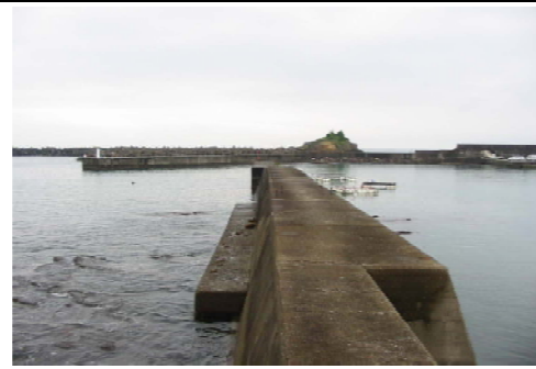
②堤防状況
