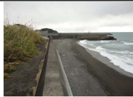
③海岸堤防状況
