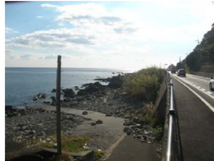
①護岸状況
