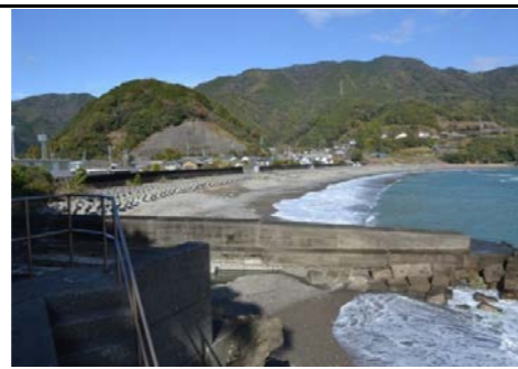
②護岸状況
