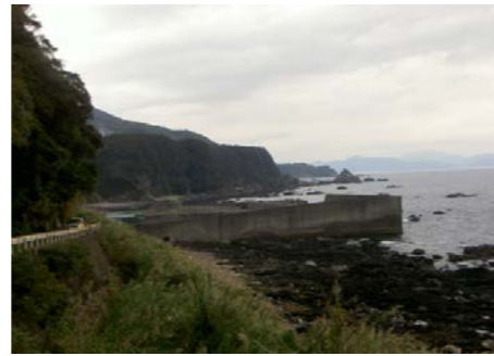
③護岸状況
