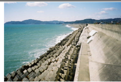
③護岸状況
