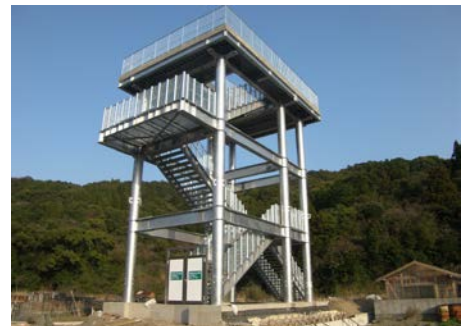
〔津波避難タワー（四万十町）〕
