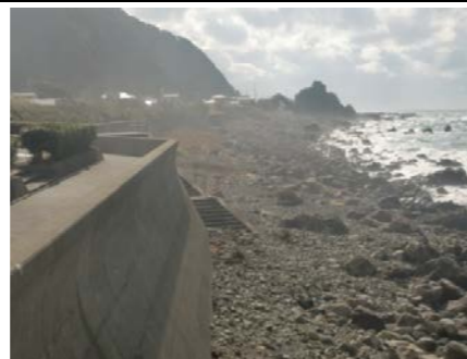
②護岸状況
