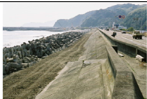
②護岸状況
