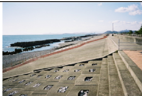
②護岸状況
