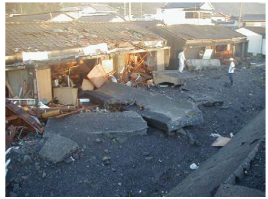
〔菜生海岸被災状況（室戸市）〕
