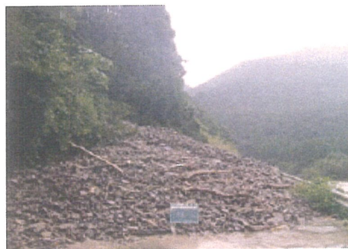
台風の影響による土砂崩れ 北川村 (H23.7.19)
