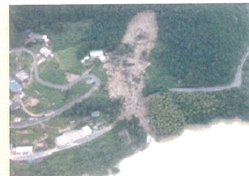
集中豪雨による土砂崩れ 大川村 (H16.8.19)
