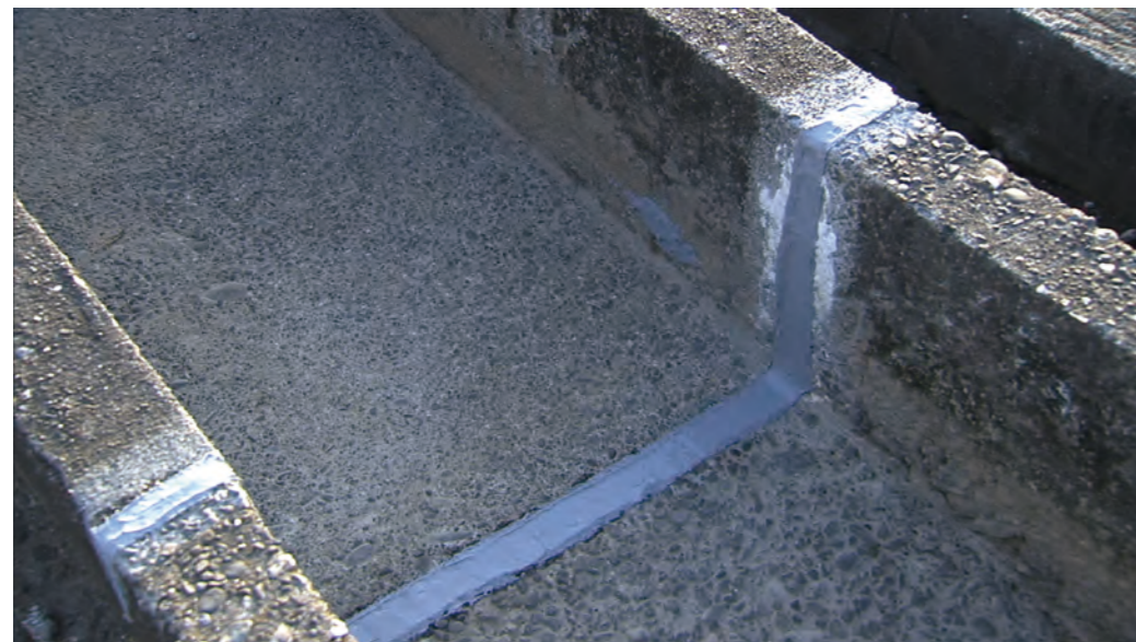
かんたん！長持ち！ シーリング材を使用した『目地』補修
