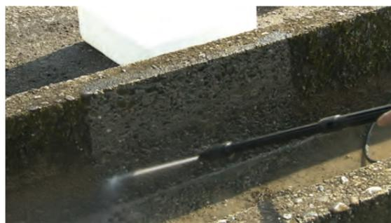
補修箇所周辺のゴミ・ホコリを高圧洗浄機で洗い落とす。
