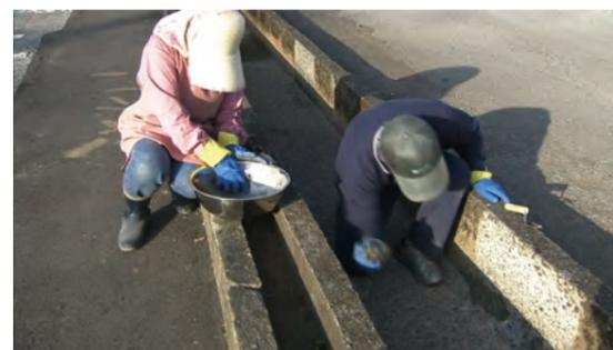
ボール状にしたモルタルを補修箇所にぶつけ、空気が入らないように穴ぼこを埋めていく。
