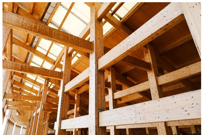
写真5 大屋根リング（内部）
