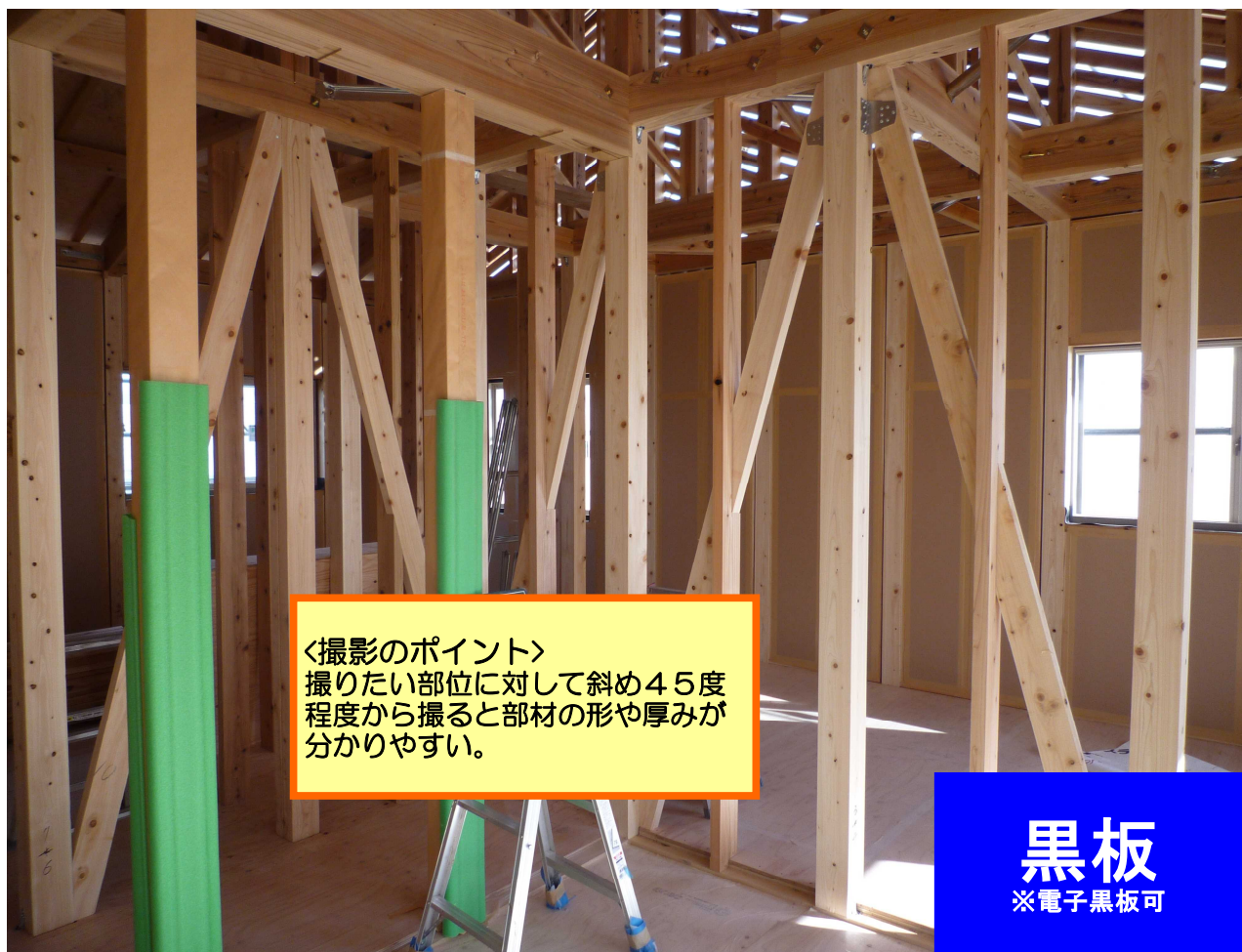
管柱・間柱・筋交
