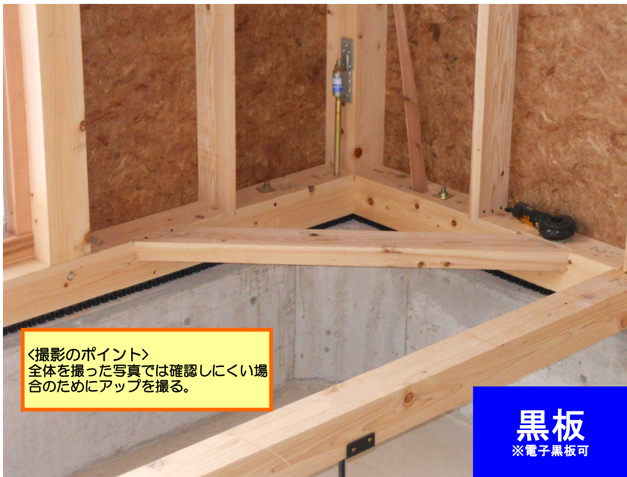
土台・大引・土台火打(寄り)
