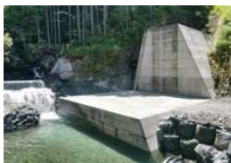
【谷山川 砂防えん堤】
