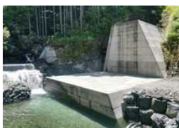
【谷山川 砂防えん堤】
