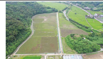
【加持地区(黒潮町) ほ場整備】
