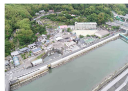
河川堤防の耐震対策
