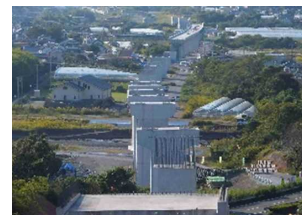
高知東部自動車道 南国安芸道路(安芸市)
