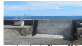
コンクリートによる陸こうの閉鎖
