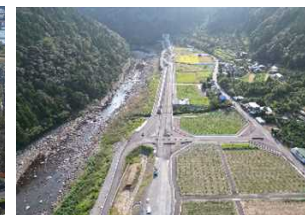
国道493号 (北川道路2-2工区)
