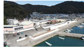
海岸堤防の耐震対策
