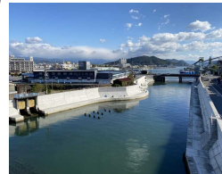
海岸堤防の耐震対策
