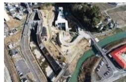
日下川（放水路整備）
