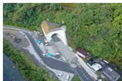
安田東洋線におけるトンネル整備
