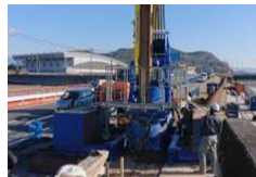
河川堤防の耐震対策
