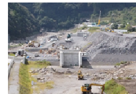
国道493号 (北川道路2-2工区)
