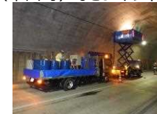
歯朶ノ浦トンネルの補修状況
