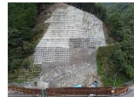
安田東洋線(安田町正弘～北川村二又地区)
