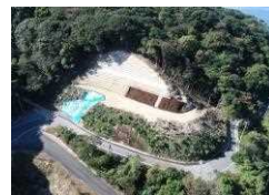
安満地福良線における線形改良
