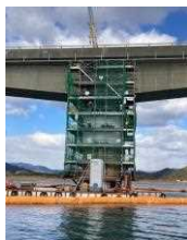
須崎仁ノ線 仁淀川河口大橋
