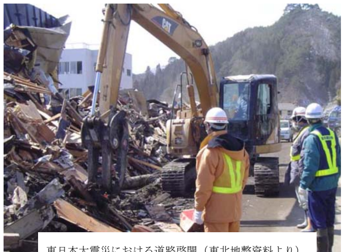
東日本大震災における道路啓開（東北地整資料より）
