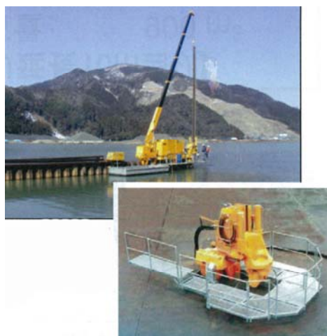
鋼矢板の圧入工法
