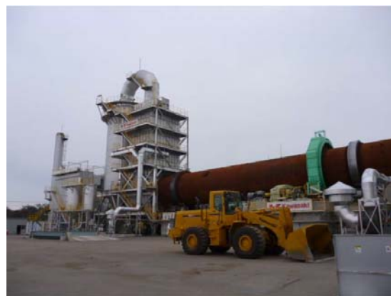
図 仙台市荒浜地区の仮設焼却施設 （焼却能力 300t/日）
