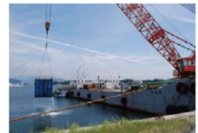
クレーン付き台船によるコンテナ引き揚げ
