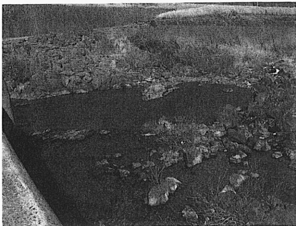
大正町向山沈下橋直下の右岸凹部採水場所
