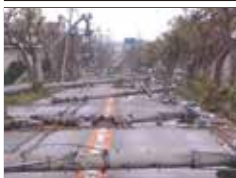
〈電柱の倒壊による道路閉塞〉
