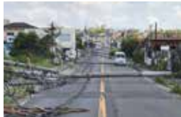
(平成30年台風第21号(大阪府泉南市))
