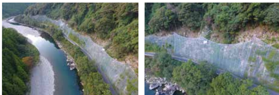
国道493号(安芸郡北川村)
