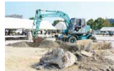
▲通行の妨げとなる土砂の撤去
