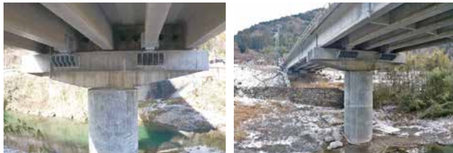
国道197号 北川2号橋(津野町)
