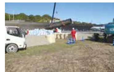
▲仮設道路の設置
