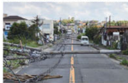
〔平成30年台風第21号(大阪府泉南市)〕
