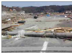
道路の 防災性能の向上
