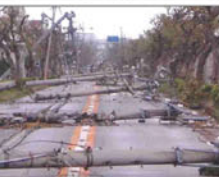
〈電柱の倒壊による道路閉塞〉
