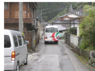
▲幅員が狭隘で通行が困難(県道中津公園線:仁淀川町)
