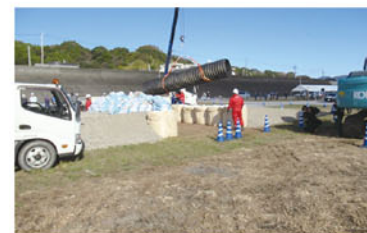
▲ 仮設道路の設置
