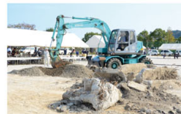
▲ 通行の妨げとなる土砂の撤去
