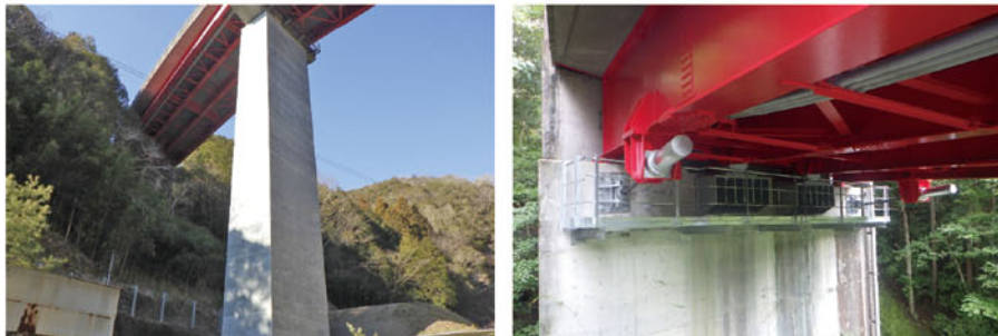
国道197号 桃ノ木大橋(津野町)
