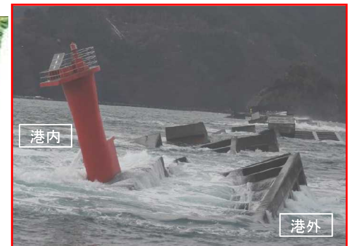
(撮影) 北堤の倒壊状況
