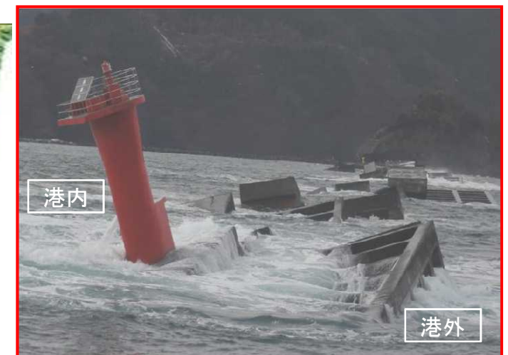
(撮影) 北堤の倒壊状況
