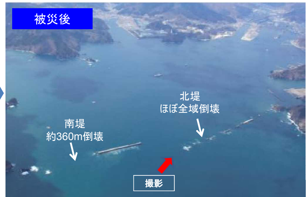
(撮影) 北堤の倒壊状況
