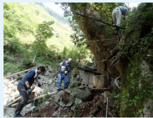
電気柵の設置作業
