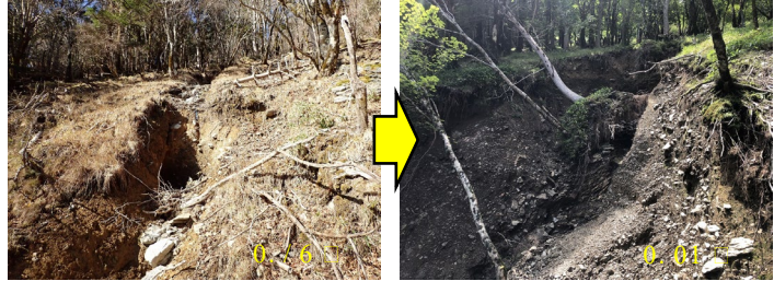
侵食が進む山腹斜面
