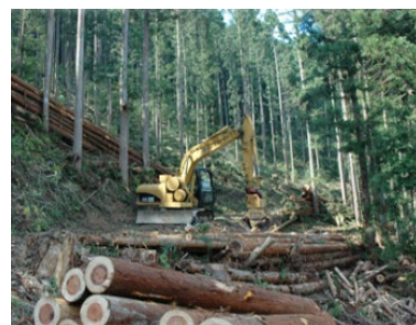
近代の重機を使った林業
