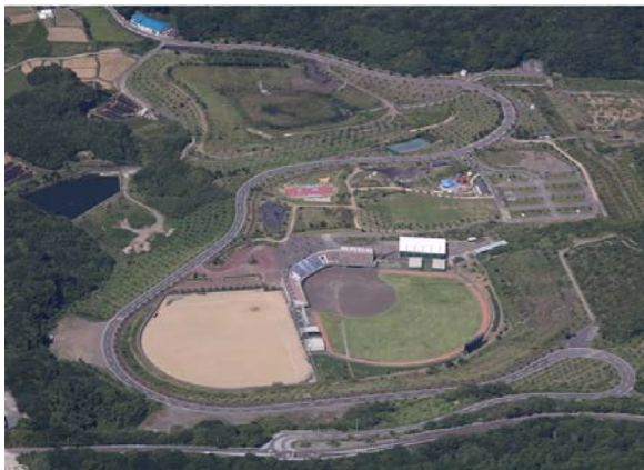
室戸広域公園（屋内運動場整備工事）
