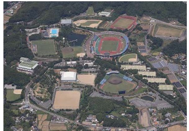
春野総合運動公園（体育館の空調設備改修工事）
