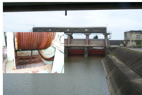
老朽化が進行した水門を改築（香宗川）
