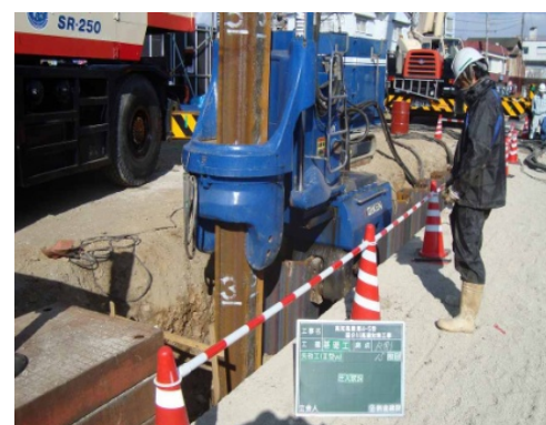
堤防の耐震補強を実施（国分川）
