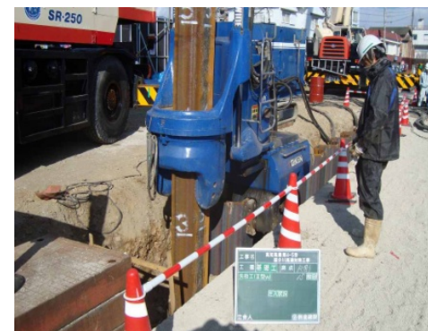
堤防の耐震補強を実施（国分川）
