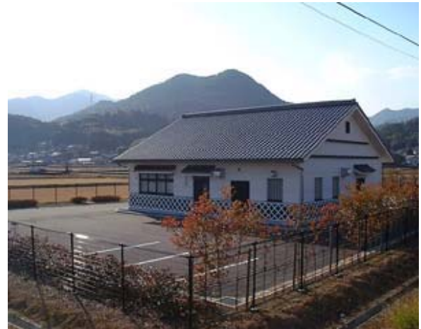
生活排水処理施設
