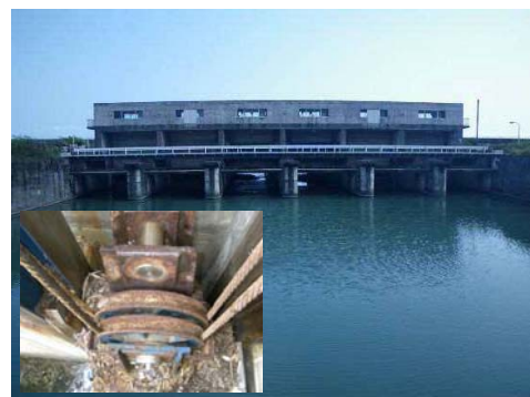
老朽化が進行した水門を改築（後川放水路）
