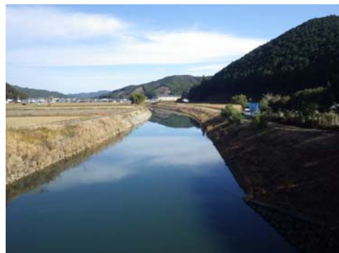
河道拡幅等の河川改修を実施（仁井田川）
