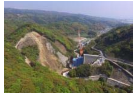
和食ダム 本体工事施工状況
