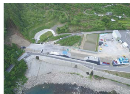
阿南安芸自動車道 北川道路 2-2 工区 (北川村)
