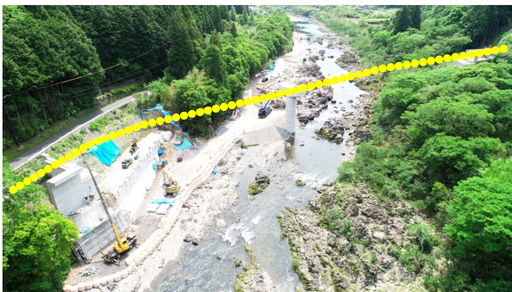
国道439号木屋ヶ内バイパス（四万十町）
