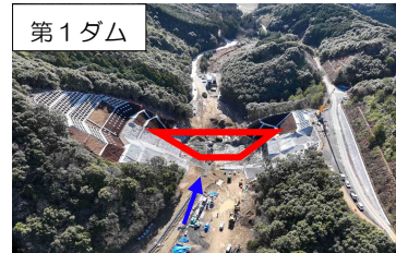
春遠第1ダム 本体工事施工状況
