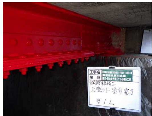
県道奈比賀川北線（さる谷橋）
