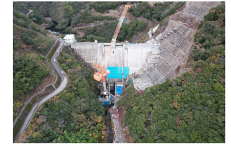
＜建設中の和食ダム＞
