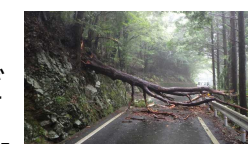
倒木状況（国道493号）
