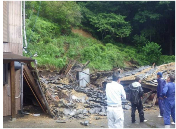
がけ崩れにより全壊した人家 (令和3年7月/宿毛市)
