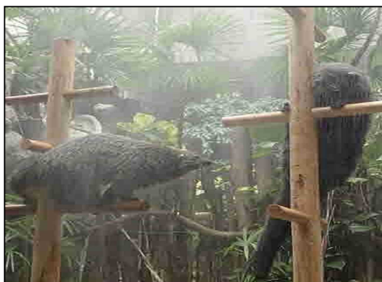
野市総合公園（のいち動物公園） ジャングルミュージアムの修繕
