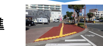
地域の安全安心推進事業（舗装修繕）
