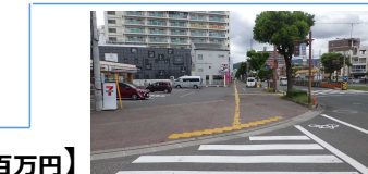
地域の安全安心推進事業（舗装修繕）
