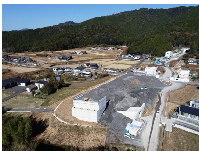
四国横断自動車道 窪川佐賀道路 (四万十町)
