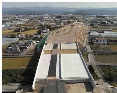
高知東部自動車道 南国安芸道路 (香南市)
