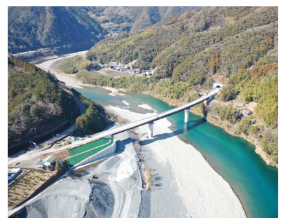
高知松山自動車道 越知道路 2 工区 (越知町)
