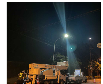
道路照明LED化
