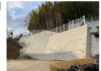
＜土砂災害対策（急傾斜地崩壊対策事業）＞
