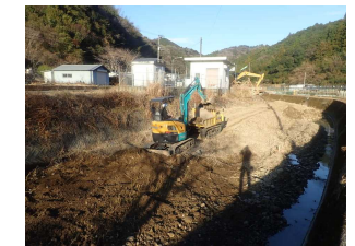
＜河川に堆積した土砂の浚渫＞
