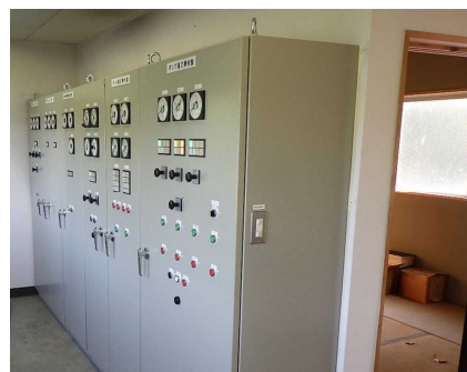
老朽化に伴う遠方操作盤更新（十市川排水機場）
