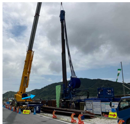
堤防の耐震補強を実施（下田川）
