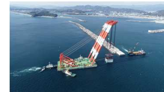
防波堤の延伸（高知港）
