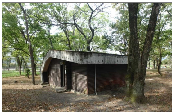
土佐西南大規模公園（大方地区） キャンプ場の改修
