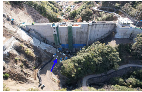
和食ダム 本体工事施工状況
