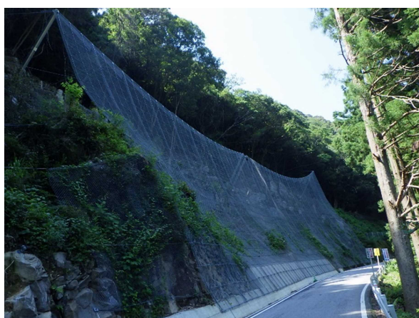
国道 493 号 (安芸郡北川村)
