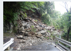
道路崩土 (県道大川土佐線)
