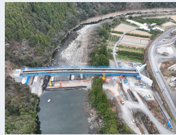
四国8の字ネットワーク (北川道路2-2工区)
