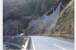
法面防災対策 (県道安田東洋線)
