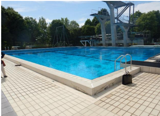
春野総合運動公園 飛び込みプール修繕
