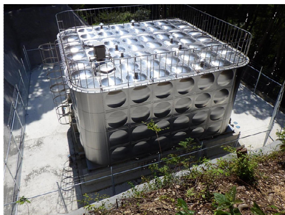
配水池の耐震化
