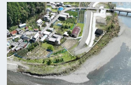
河川の堤防整備 (安芸川)
