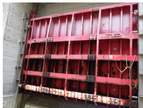
老朽化に伴う水門更新（新川川甲殿樋門）
