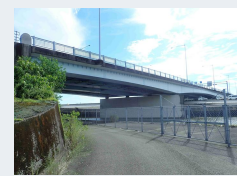
橋梁耐震対策 (国道195号 曙大橋)
