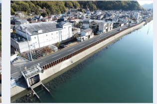
河川堤防の耐震化 (下田川)
