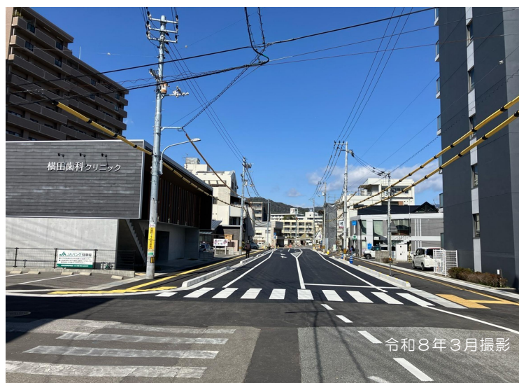
旭駅城山町線（旭町工区）の整備状況
