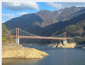
橋梁の長寿命化修繕 (県道本川大杉線 上吉野川橋)
