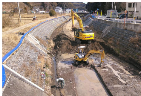
護岸整備等を実施（奥田川）
