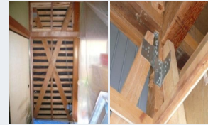
耐震改修工事
