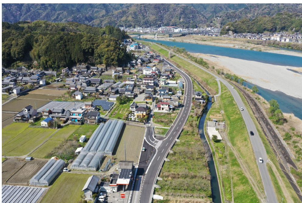
県道土佐伊野線 大内工区（いの町）
