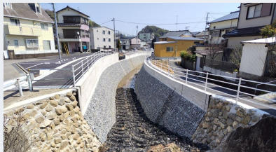
河川改修 (蒔野川)
