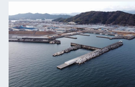
港湾の防波堤整備 (高知港)
