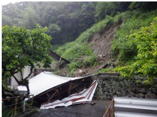
がけ崩れの発生状況 (令和5年6月/須崎市)
