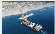
離岸堤の整備 (野根海岸)
