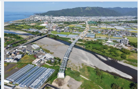
四国8の字ネットワーク 阿南安芸自動車道 安芸道路
