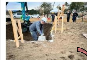
手元作業員の多い現場
