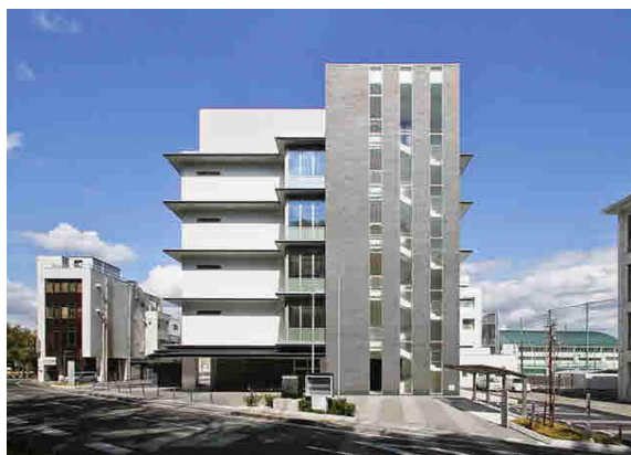
高知県保健衛生総合庁舎
