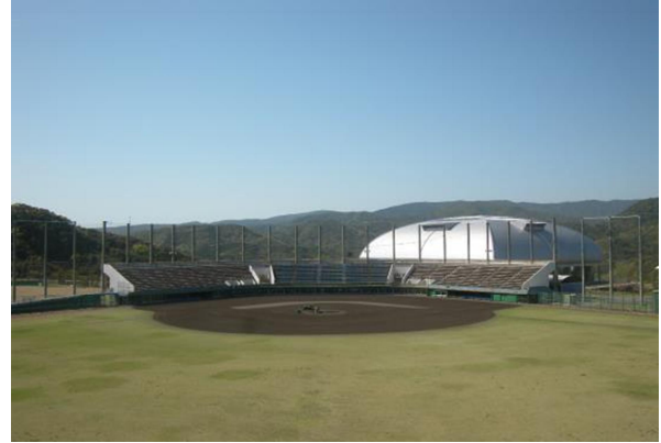
室戸広域公園 野球場の改修
