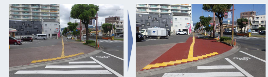
地域の安全安心推進事業(舗装修繕)
