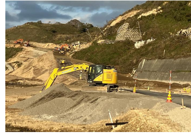
危険を伴う現場で建設機械を遠隔操作
