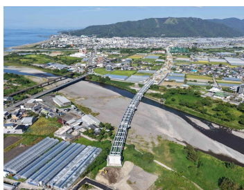
阿南安芸自動車道 安芸道路 (安芸中IC~安芸東IC)
