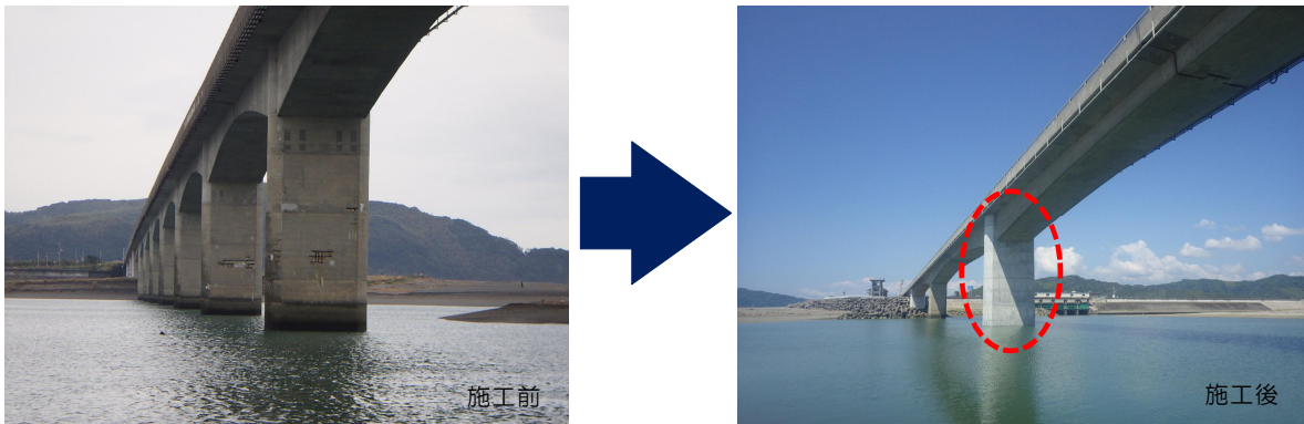
県道須崎仁ノ線（仁淀川河口大橋）
