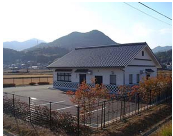
生活排水処理施設
