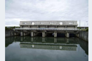
施設点検予定箇所 (後川防潮水門)
