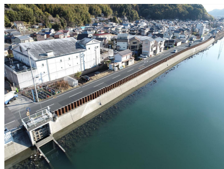
堤防の耐震補強を実施（下田川）
