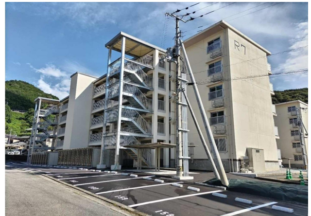
改善工事完了
