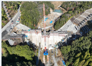
ダム建設 (春遠第1ダム)
