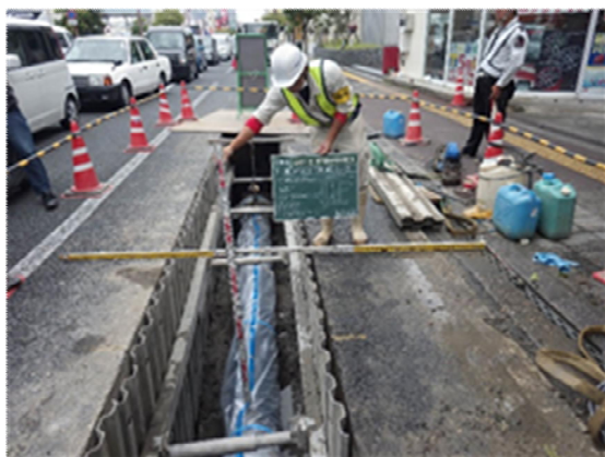
耐震管への布設替え
