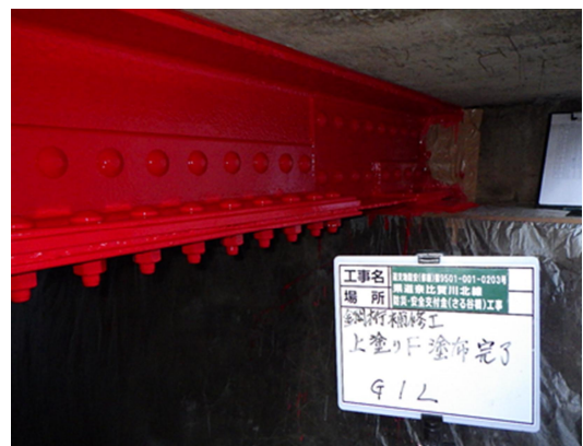
県道奈比賀川北線（さる谷橋）
