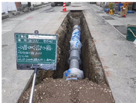
耐震管への布設替え
