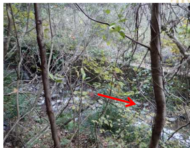
谷川と護岸を確認(水量は多い) (右岸から撮影)
