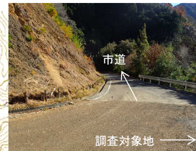
林道(これより奥は未舗装)
