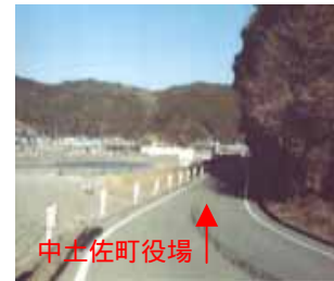
現道は海岸線に沿った道路
