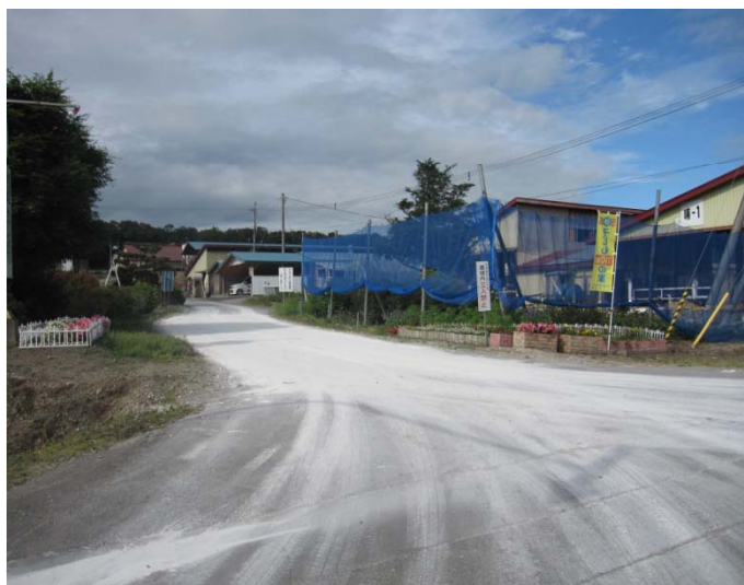
消石灰帯の設置
