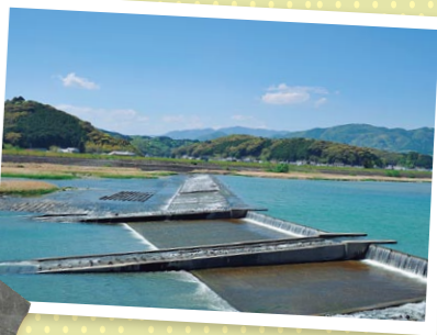
仁淀川の水を平野部へ取り込む八田堰。「く」の字に曲げてあり、増水しても流されない構造です。
