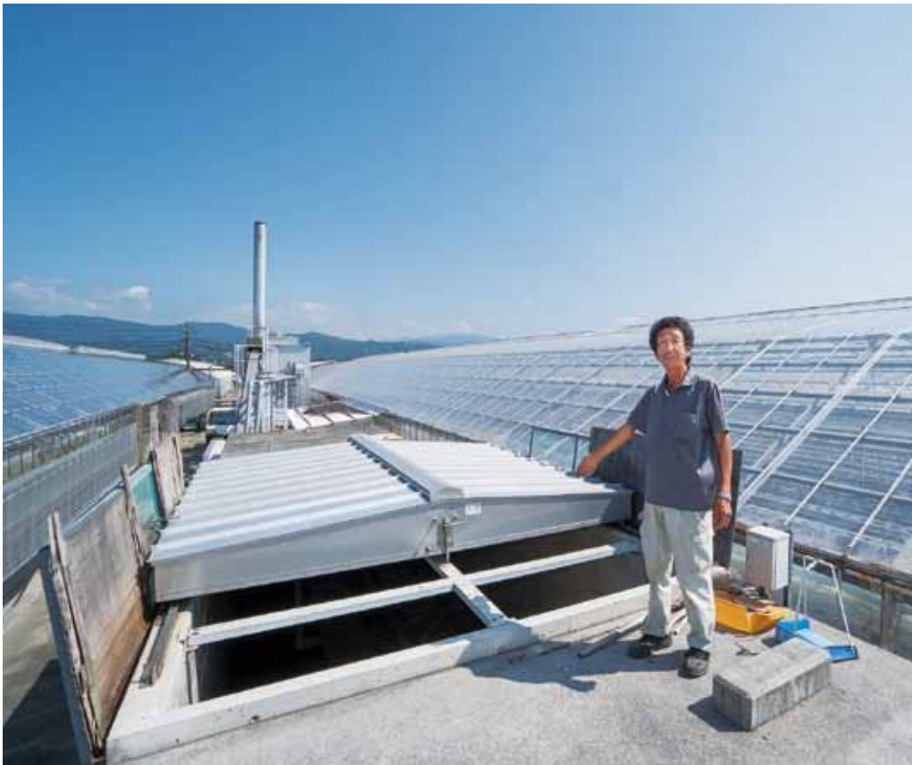
木質チップの搬入口。ここに10tトラックが乗り付け入れていきます。橋田さんはチップの含水率(木に含まれる水分割合)を6ヶ所で測り、燃え方の調整をしています。
