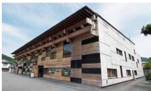
総合庁舎では太陽光発電をしています。
