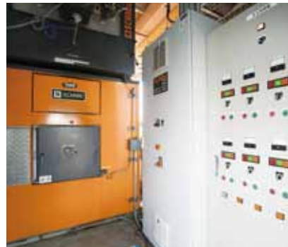
木質チップボイラーの心臓部といえる機械室。ボイラーの運転、停止時の対応、栽培ハウスの温度管理等を自動で行っています。
