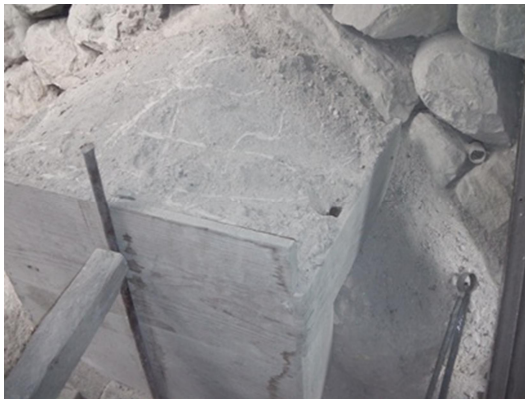
窯壁外周の石垣はアーチ構造
