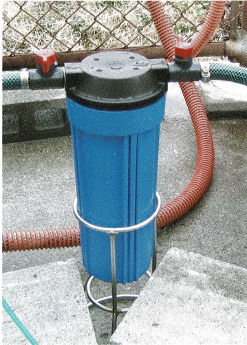
深層水のろ過に使用したカートリッジ式フィルター(1 \mu m)
