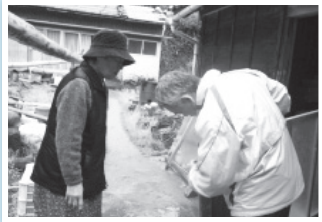
玄関引き戸 / 戸車の散り替え
