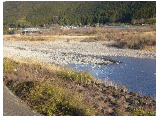
瀬切れの状態 (戸板島橋上流付近)
