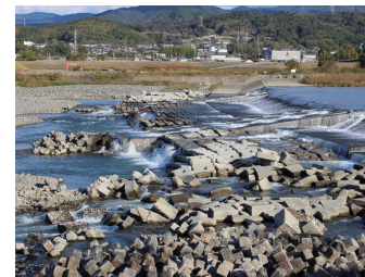
堰下流の河床低下に伴う水面落差のため機能しにくい魚道（統合堰）
