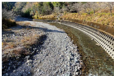
護岸前面にみお筋が寄り付き河床地形が単調化した場所（物部川本川 べふ峡温泉前）
