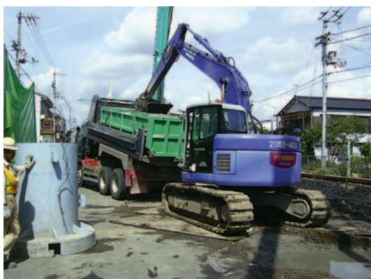
建設汚泥積込状況
