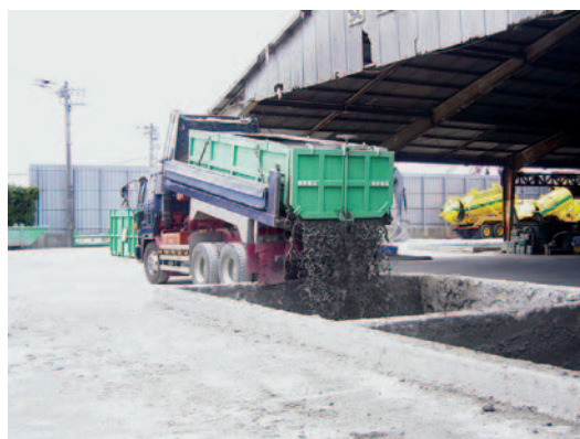
建設汚泥改良槽投入状況
