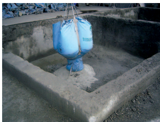
固化剤投入状況
