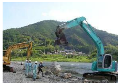
多自然川づくり施工の様子 (いの町柳瀬地区)
