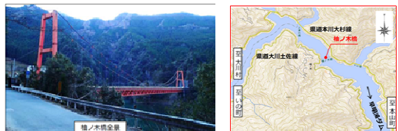
写真は土佐町に昭和46年10月建設の柚木橋(ゆのきばし)
