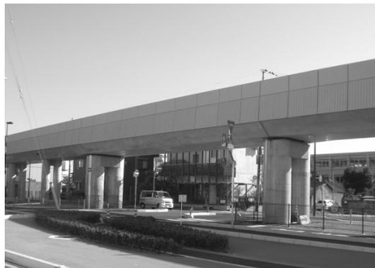
3 径間連続 H 鋼埋込桁(スパン 20m 以上)
