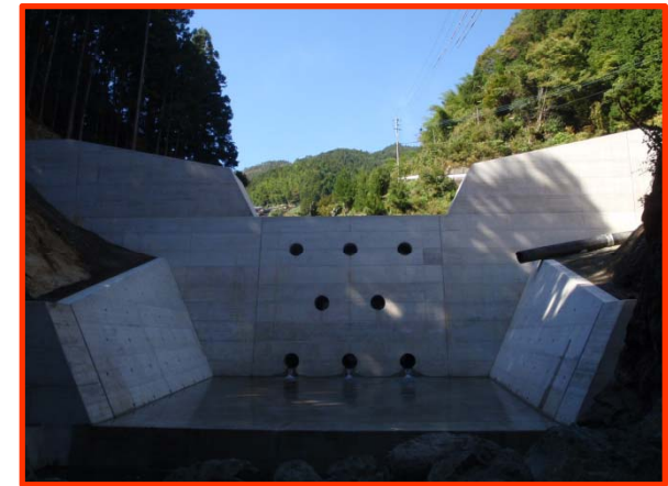
1号堰堤完成写真 (H=10.0m, L=49.3m)
