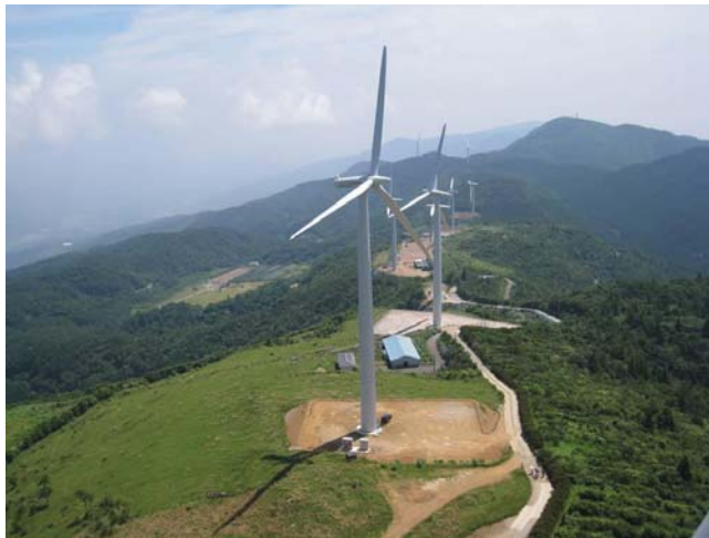
写真 5-1：敷地造成の事例（徳島県大川原ウインドファーム）
