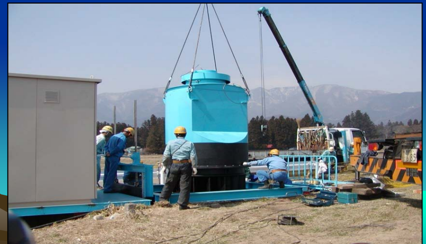
④架台の上に水車発電機を設置
