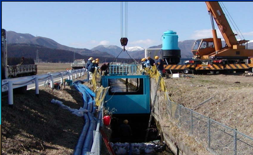
③水車発電機の架台を設置
