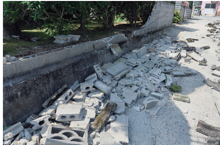
ブロック塀が たおれる (ていきょう 防災システム研究所)
