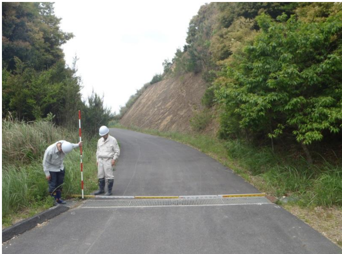
町道付替え道路（ダムサイトより下流区間）
