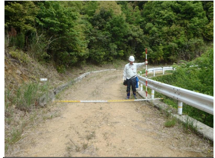
町道付替え道路（ダムサイトより上流区間）
