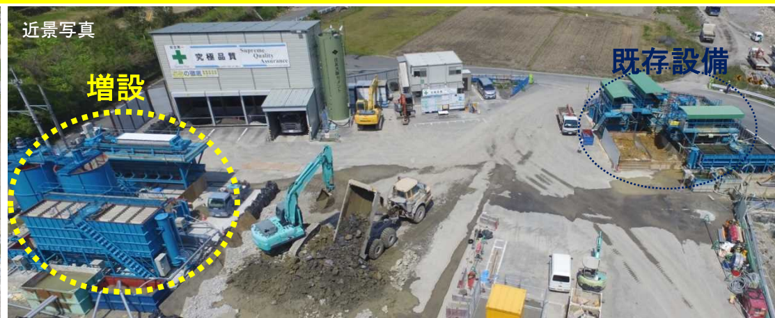
濁水処理設備増設
