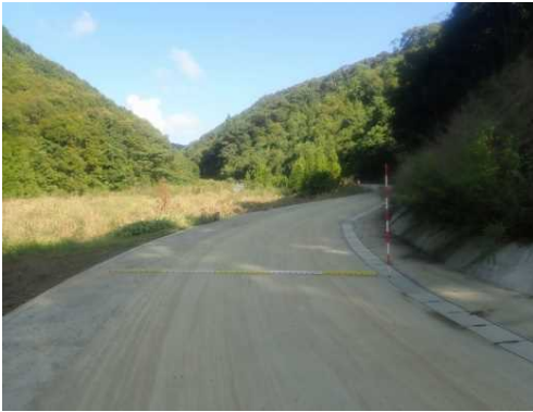
春遠第1ダム 左岸工事用道路
