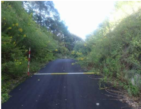
春遠第1ダム プラントヤード連絡通路
