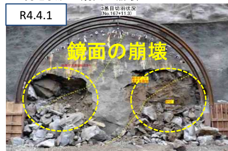
&lt;現地状況&gt;鏡面の崩壊
