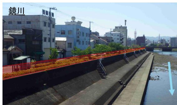
堤防のL1津波対策(堤防の嵩上げイメージ)
