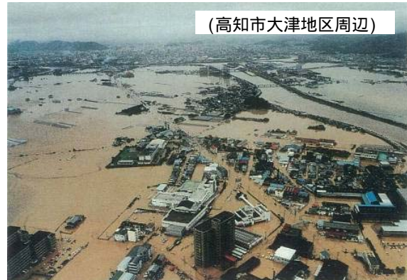
98 高知豪雨による浸水状況
