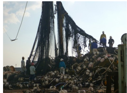
図12 平成24年10月に芸東地区を襲った大急潮によって被害を受けた定置網の解体風景
